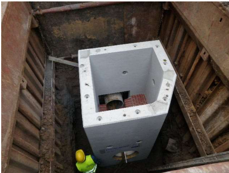
Foto : Kanalschacht im Bau (Breddestraße)
