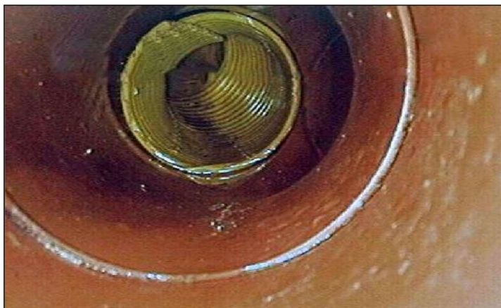
Bild: Drainageanschluss (Bildreferenzkatalog Private Anschlussleitungen-MKUNLV-NRW)
