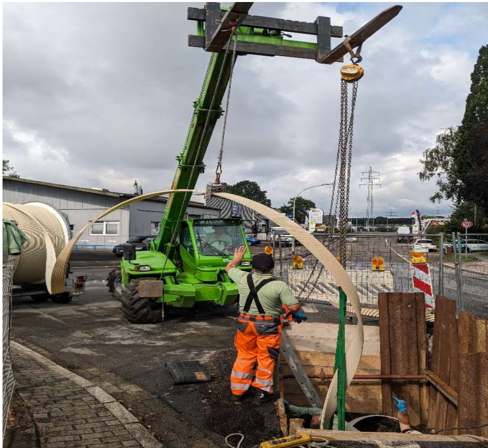
Foto: Sanierung mittels Wickelrohrverfahren im Wullener Feld
