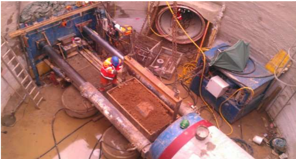
Foto : Rohrvortrieb im Bereich Bahnanlage Crengeldanz
