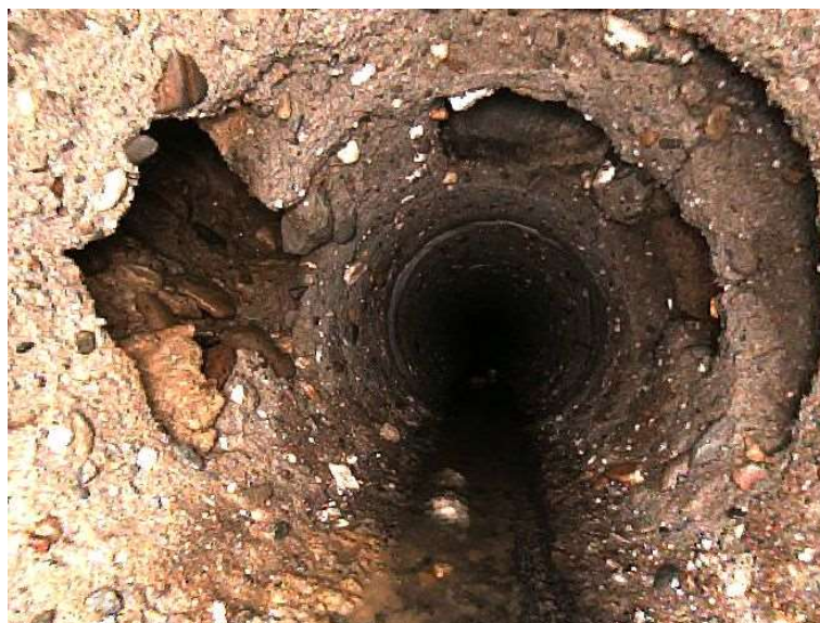
Bild : Kanalschaden ZK0 in der Potthoffstraße
